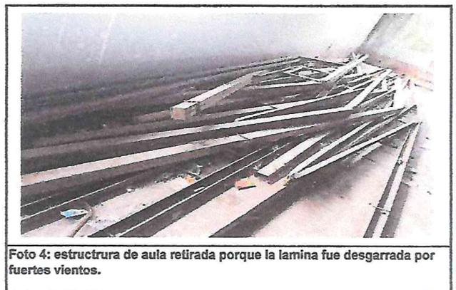
Foto 4: estructura de aula retirada porque la lamina fue desgarrada por fuertes vientos.
