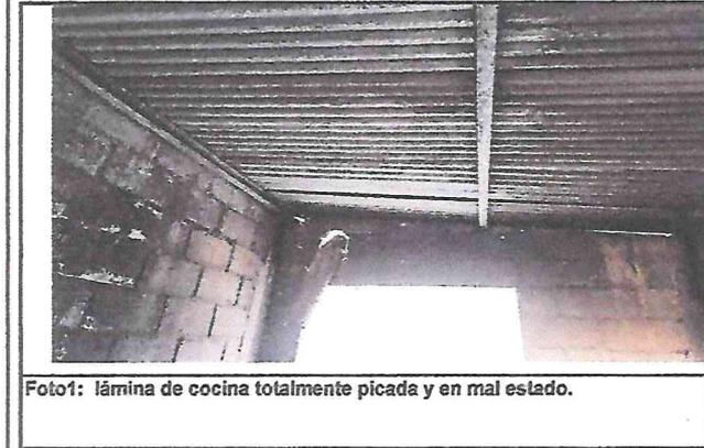
Foto 1: lámina de cocina totalmente picada y en mal estado.
